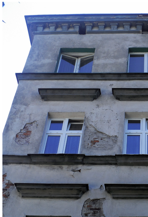
Zdjęcie nr 56 Stolarka okienna (Elewacja BC)
