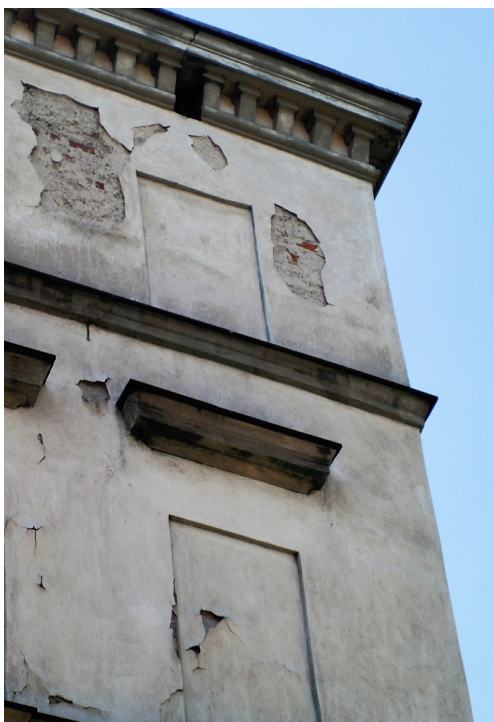
Zdjęcie nr 47 Zamurowania na elewacji AB
