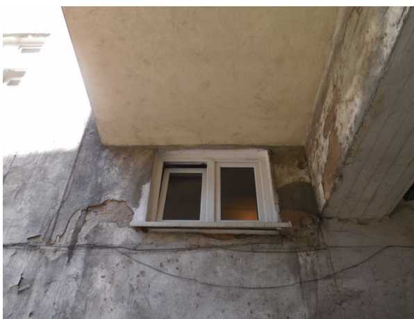
Zdjęcie nr 60 Stolarka okienna na elewacji DA
