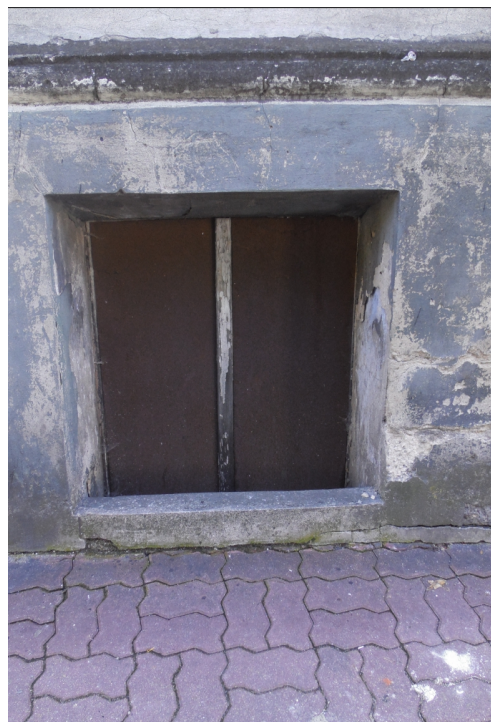
Zdjęcie nr 54 Okno piwniczne (Elewacja BC)
