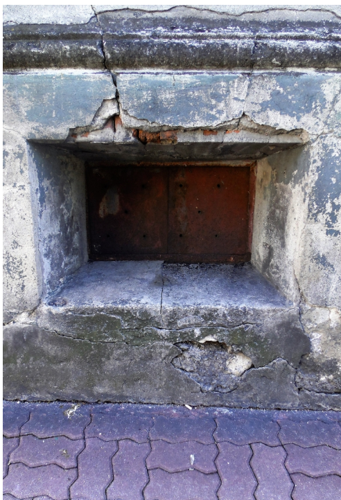
Zdjęcie nr 53 Okno piwniczne (Elewacja BC)
