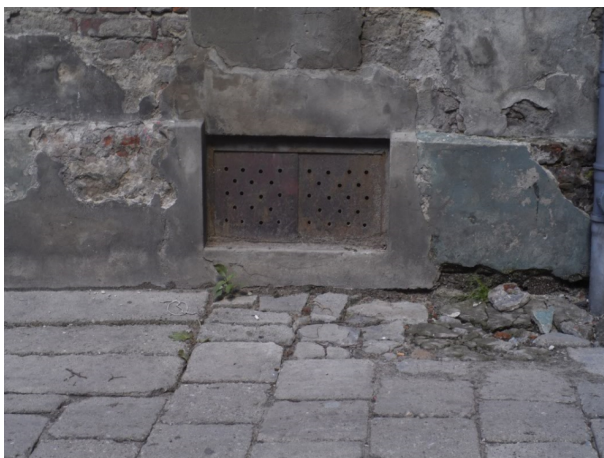
Zdjęcie nr 58 Okno piwniczne na elewacji DA
