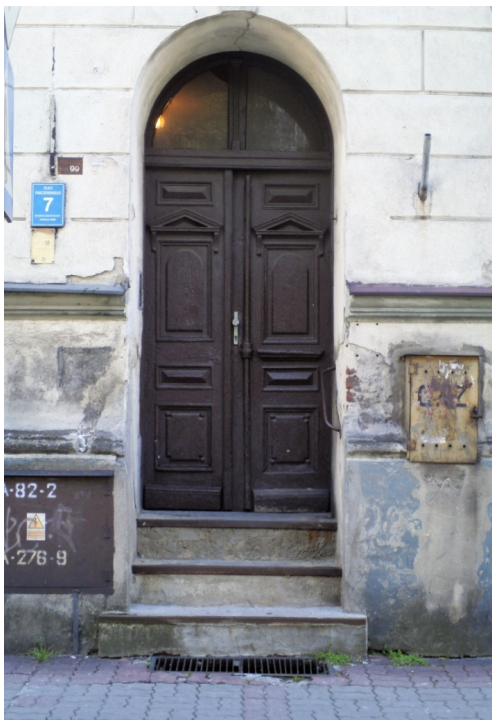
Zdjęcie nr 51 Wejście główne do budynku (Elewacja BC)
