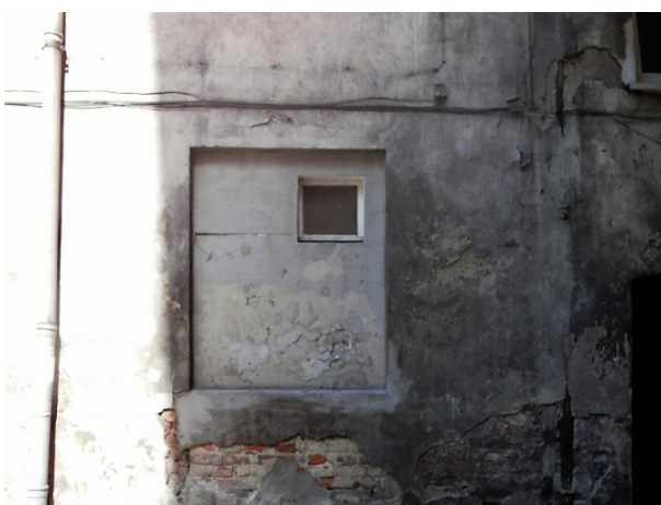
Zdjęcie nr 62 Stolarka okienna na elewacji DA
